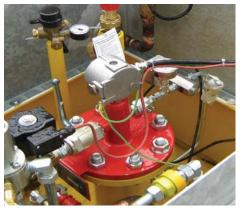
Einbaubeispiele im Domschacht eines Flüssiggasbehälters
